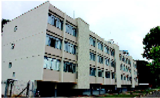
A finalização das obras e a colocação de mobiliário no alojamento Pós, no campus Viçosa, foi uma das várias ações relacionadas à moradia na UFV
