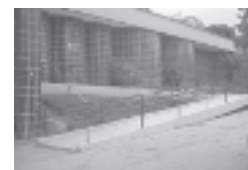
A rampa facilitará o acesso de deficientes à BBT
