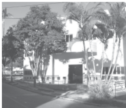
Vista frontal do prédio do DEP
