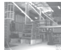
A Unidade de Beneficiamento possui instalações de alta tecnologia
